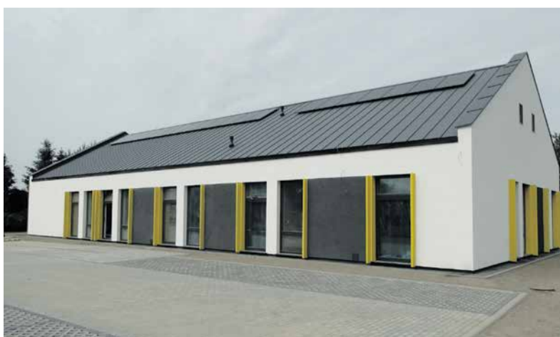
Przy ul. Sienkiewicza w Siechnicach na gminnej działce powstaje Powiatowy Środowiskowy Dom Samopomocy.
