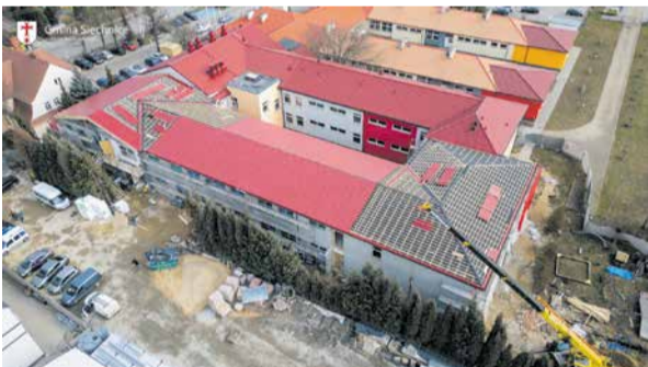
Rozbudowa Szkoły Podstawowej w Żernikach Wrocławskich (Fot. Damian Leszczyński).
